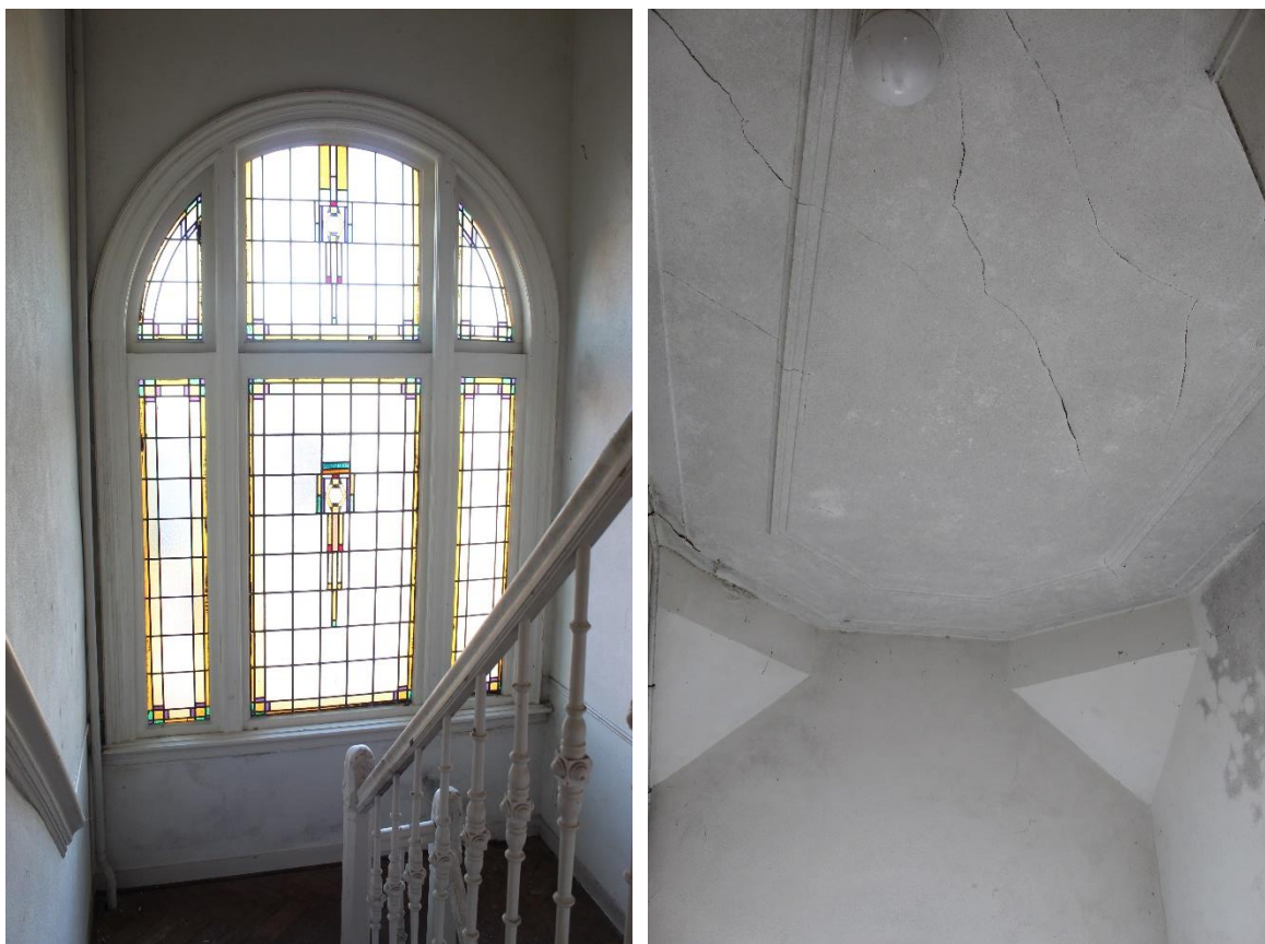
Figuur 31: Het trappenhuis ter hoogte van de zolder.
