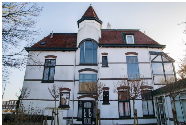
Rechterzijgevel met glas-in-loodraam in het trappenhuis. Bron: SVVOH
