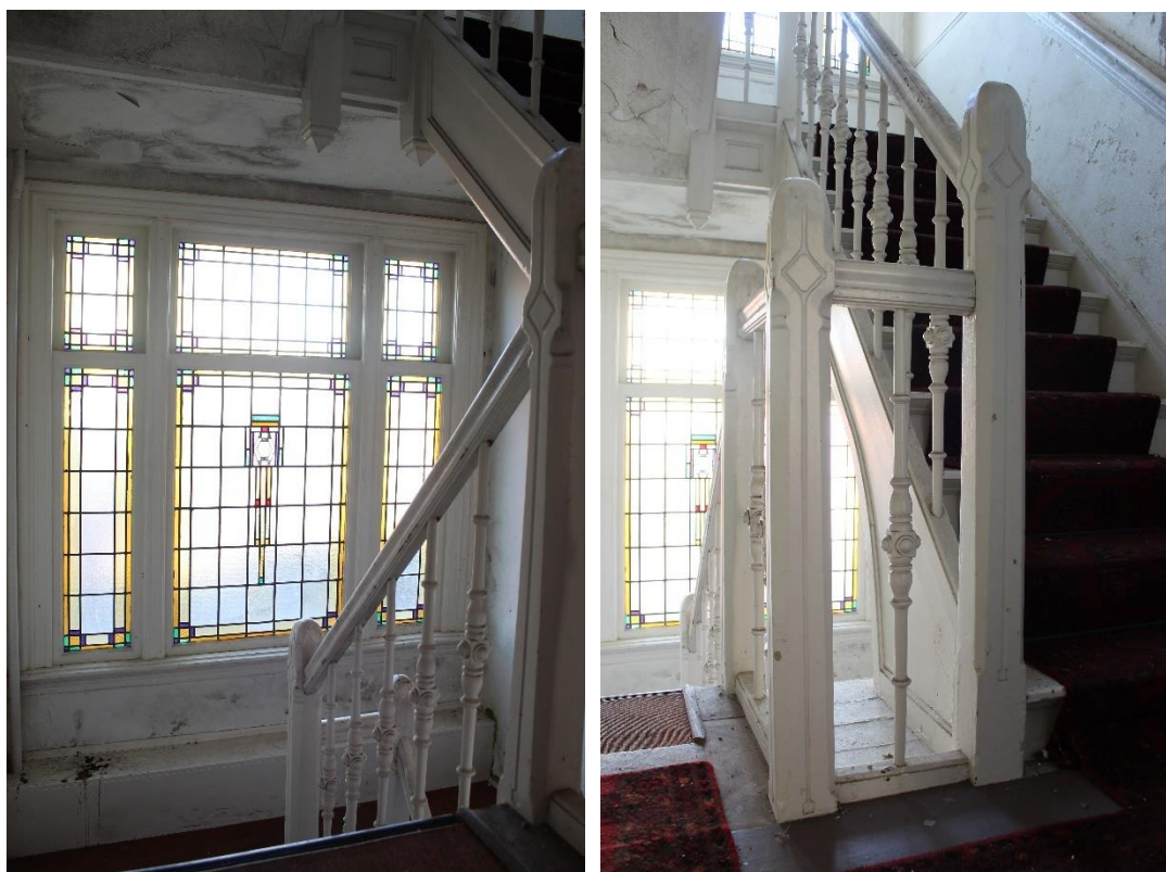
Figuur 22: Het trappenhuis op de verdieping.
