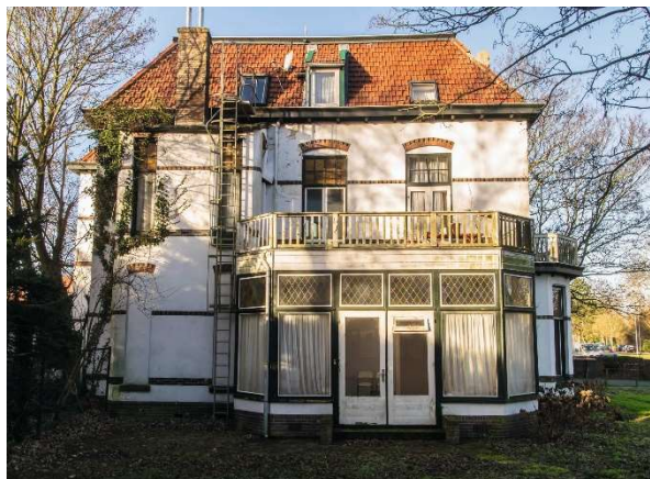
Linkerzijgevel (oostzijde) Bron: SVVOH
