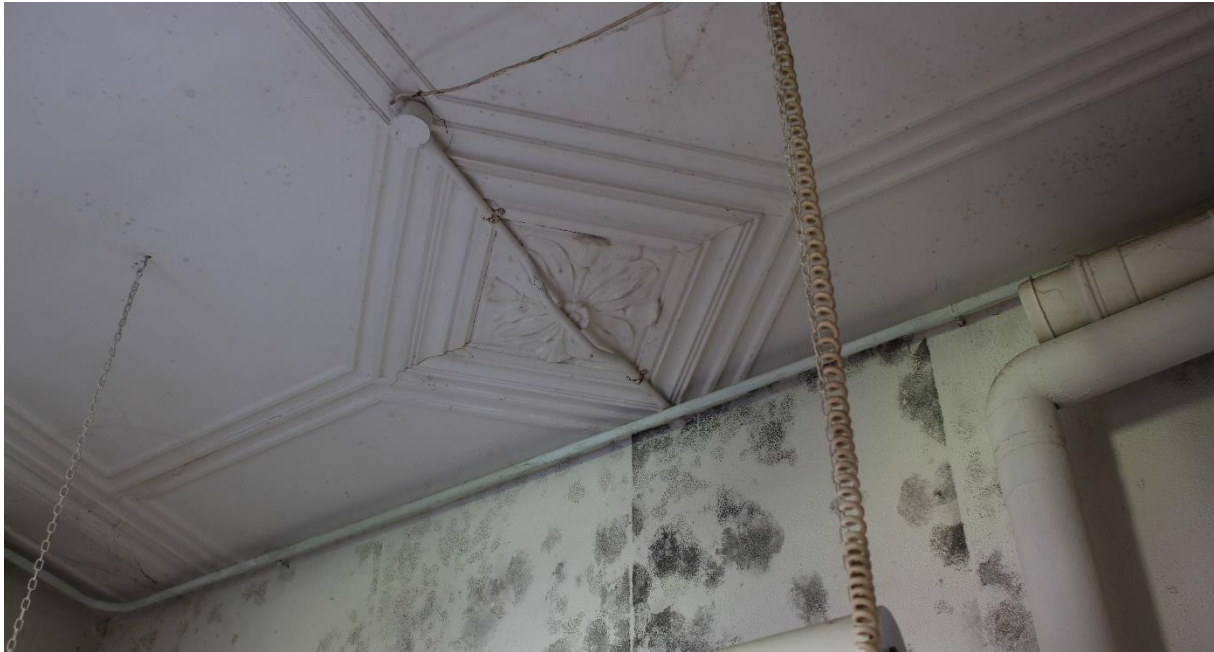
Figuur 12: Een plafond in één van de verkeersruimten op de begane grond.
