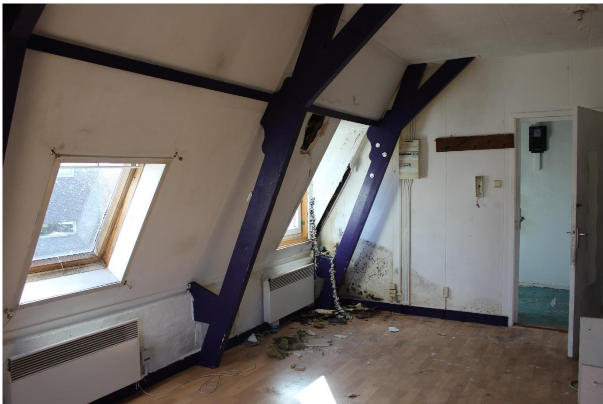
Figuur 33: De kapconstructie.
