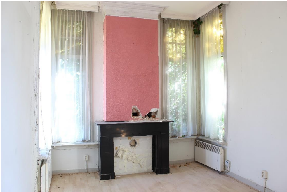
Figuur 27: De stookplaats in de rechter achterkamer op de verdieping.
