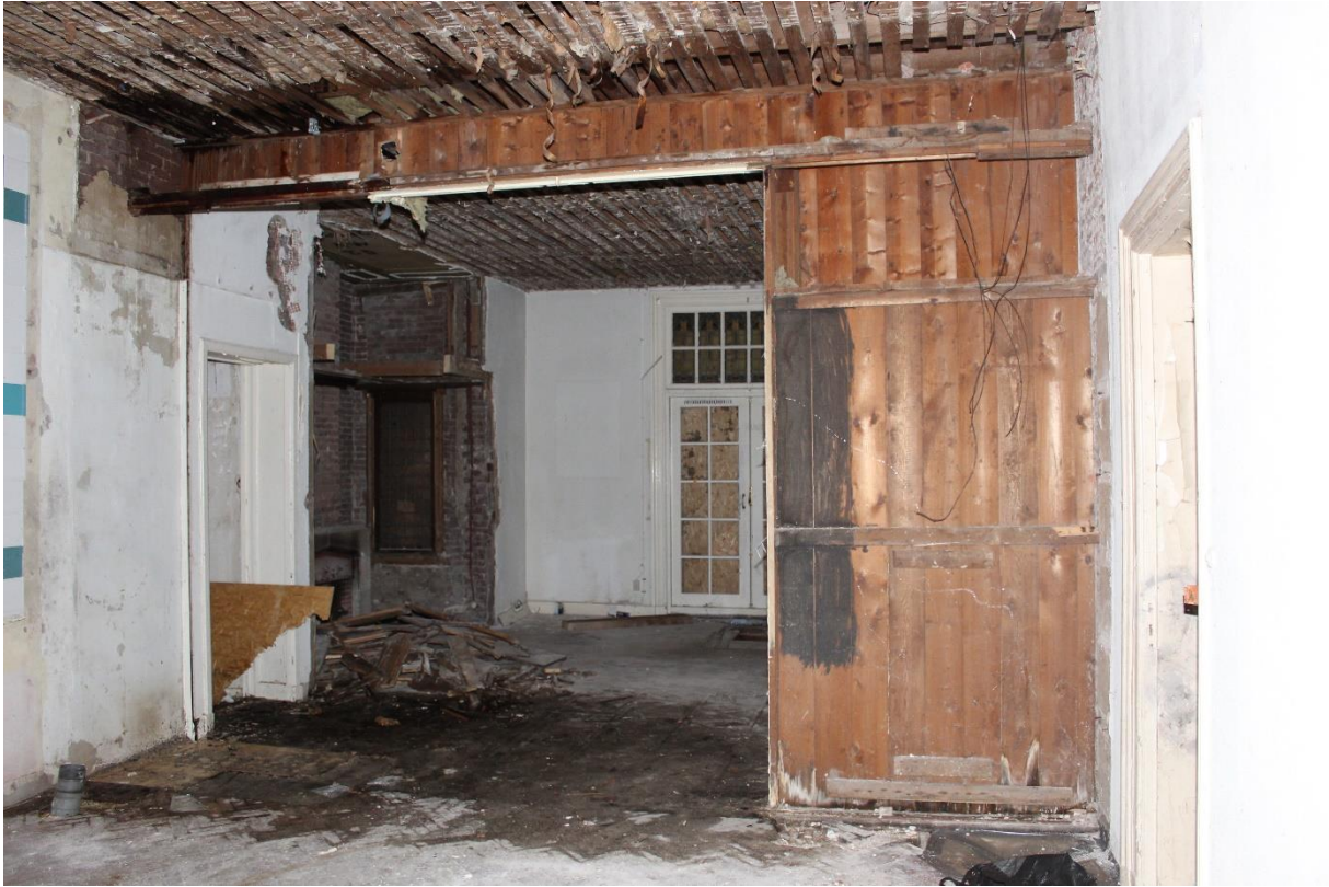
Figuur 12 Opname vanuit de voorkamer in de richting van de achterkamer, met het restant van het suitekozijn.
