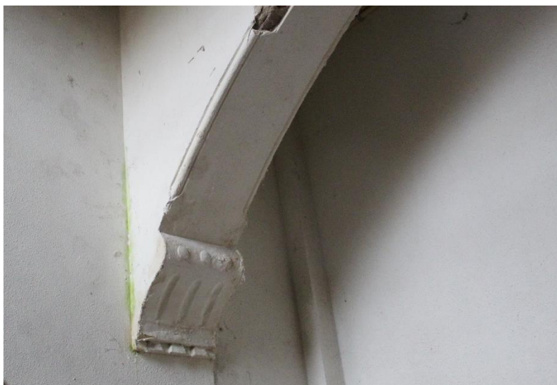
Figuur 7 Eén van de consoles op de begane grond
