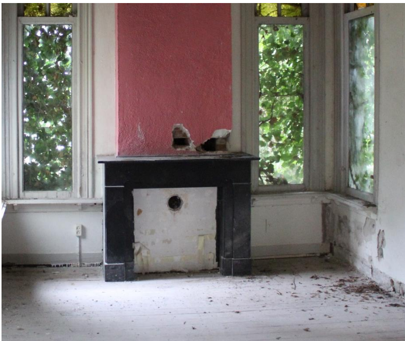
Figuur 5 De stookplaats op de verdieping
