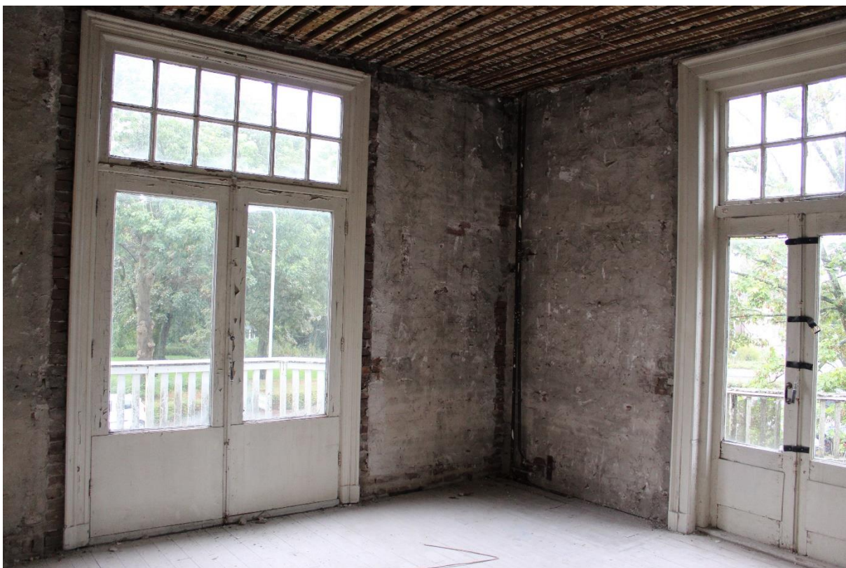
Figuur 21 Eén van de kamers op de verdieping. De situatie van de overige kamers is identiek.
