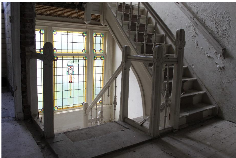
Figuur 6 Opname van het trappenhuis op de verdieping
