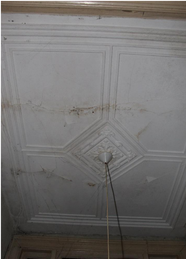
Figuur 10 Het geornamenteerde stucplafond in de hal op de begane grond
