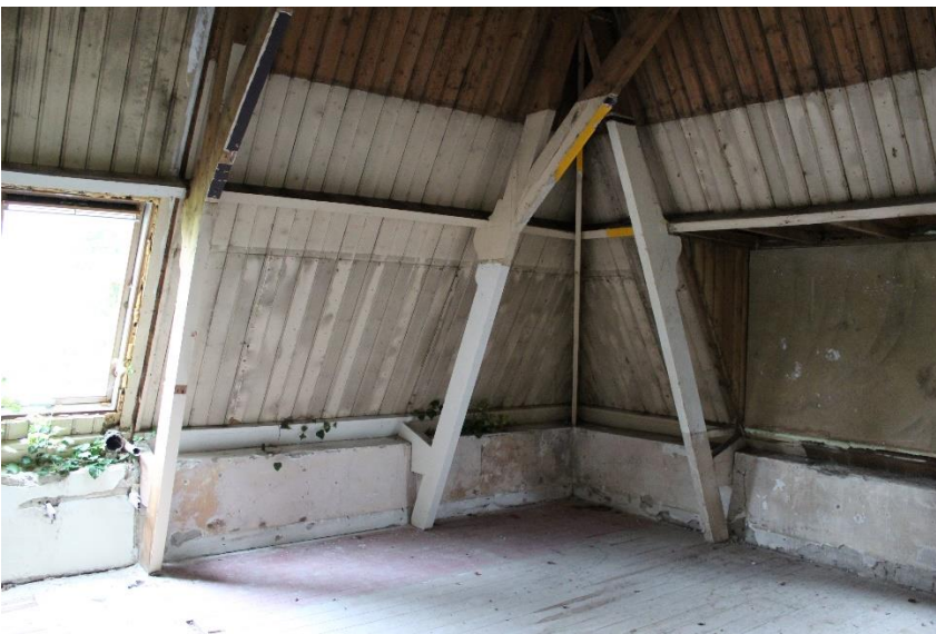
Figuur 11 Enkele opnamen van de kapconstructie
