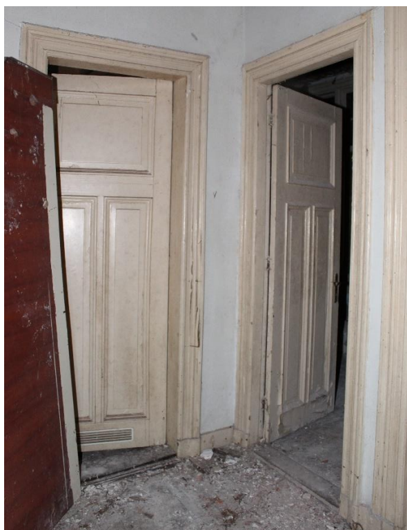
Figuur 17 Enkele deuren en deurkozijnen op de begane grond.
