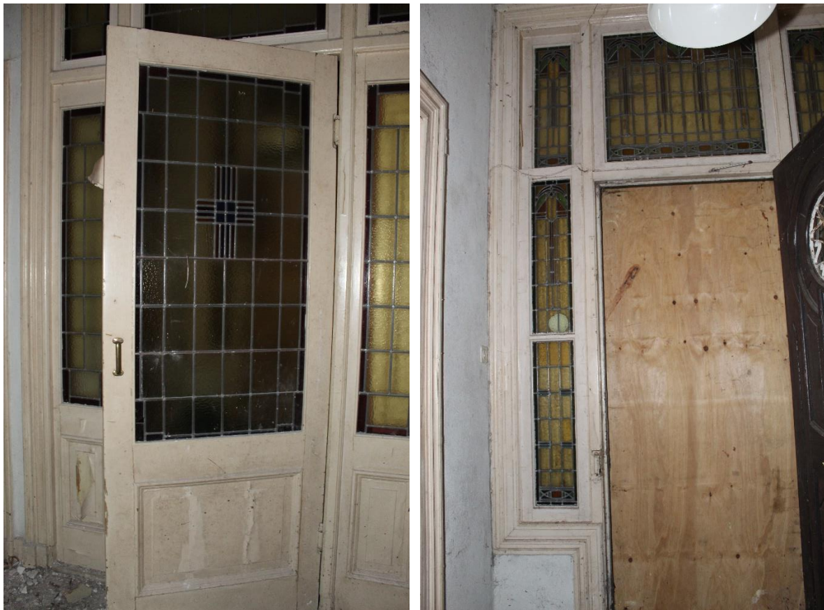
Figuur 15 Het kozijn van het tochtportaal en het deurkozijn aan de zijde van de Wilhelminalaan.
