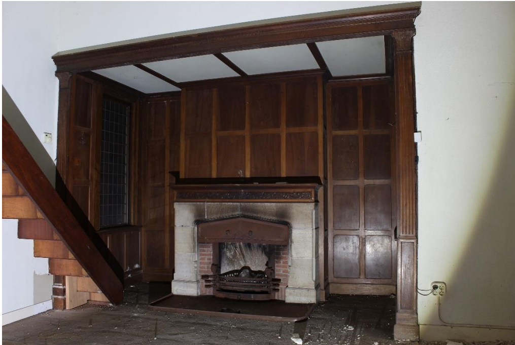
Figuur 18: De oorspronkelijke erker met representatieve houten panelen en stookplaats, aan de oostgevel.
