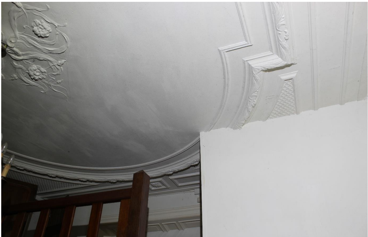
Figuur 21: De profiellijst van het plafond in de achterkamer.
