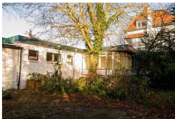
Achtergevel (zuidzijde) met oude garage en kantoorruimten Bron: SVVOH
