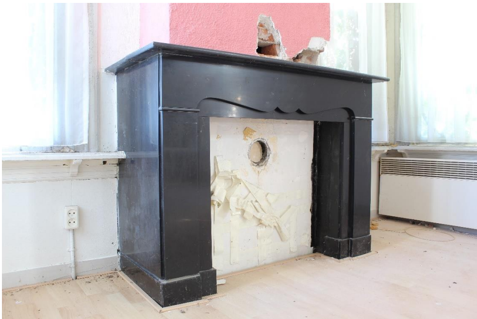
Figuur 28: Detailopname van de schouwmantel.
