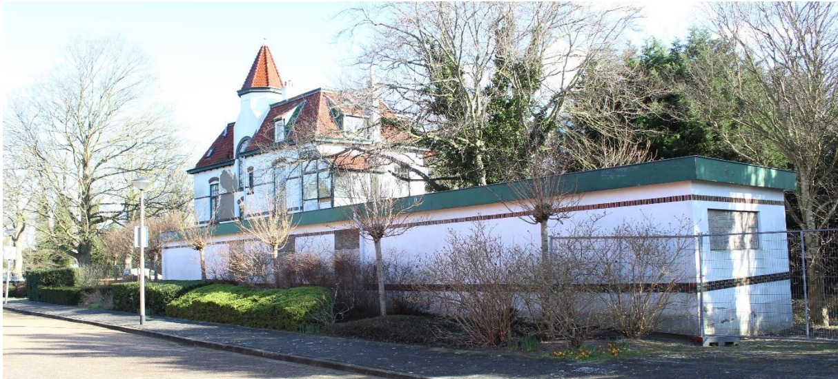
Figuur 10: Opname van de uitbouw die in 1991 werd toegevoegd.
