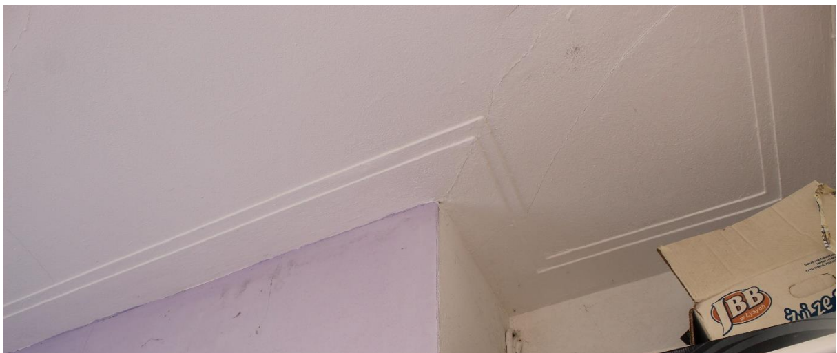
Figuur 30: Eén van de plafonds op de verdieping.
