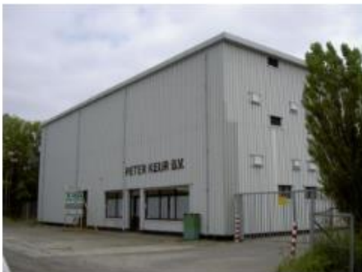
In de jaren '70 is de bollenshuur "ingepakt" in stalen damwandprofielen en is de achtergevel wit geschilderd. Deze wijzigingen zijn bij restauratie en herbestemming te herstellen.
