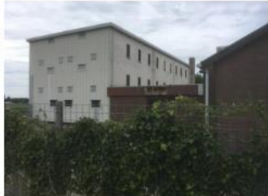
In de jaren '70 is de bollenshuur "ingepakt" in stalen damwandprofielen en is de achtergevel wit geschilderd. Deze wijzigingen zijn bij restauratie en herbestemming te herstellen.
