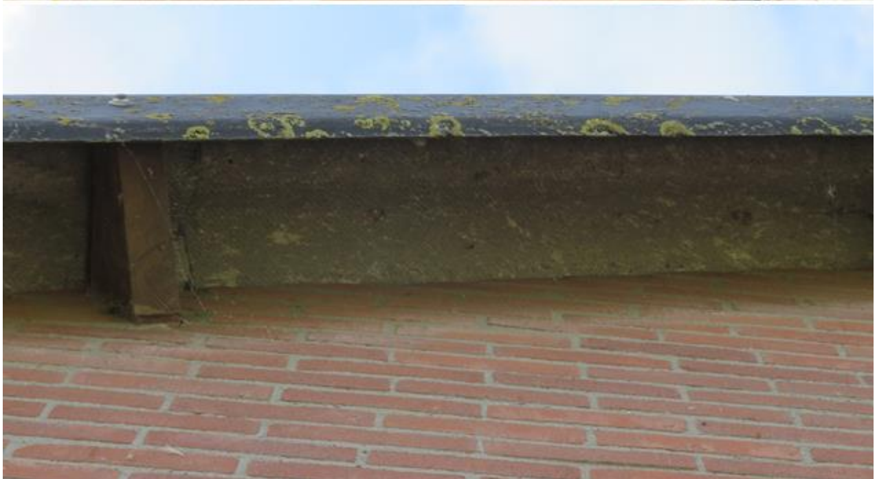
Foto's achter(noord)zijde gevel schuur
