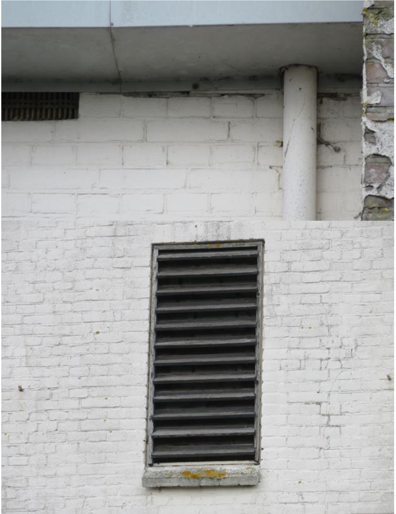
Met roosters afgedichte ventilatiegaten in kantoorgebouw/annex bollenschuur.
