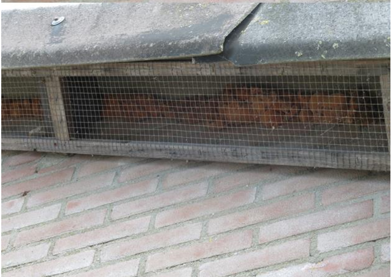
Met gaas afgedichte openingen tussen dak en voor(zuid)gevel.
