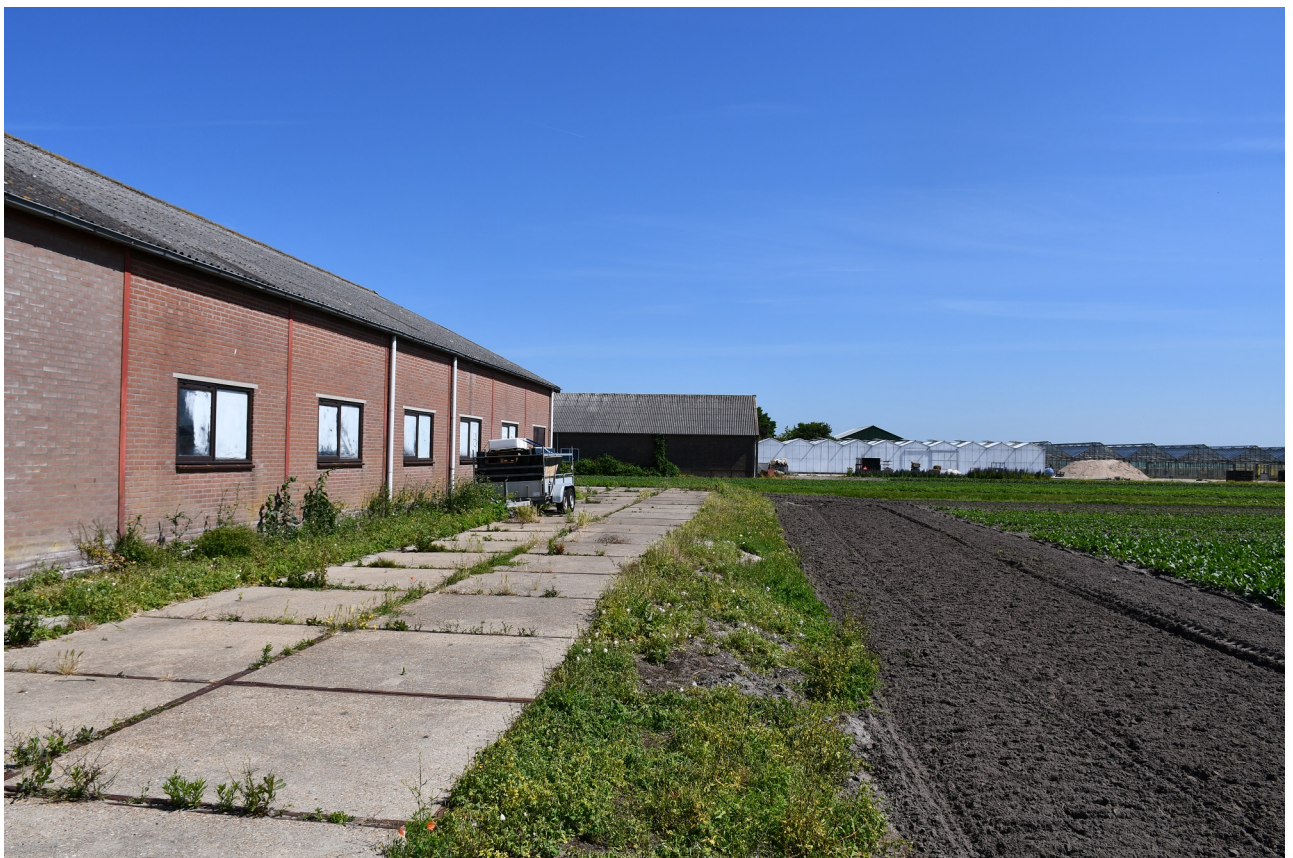
Afbeelding 3: achterzijde perceel te slopen bedrijfsgebouw en gedeelte agrarisch perceel voor dahliateelt
