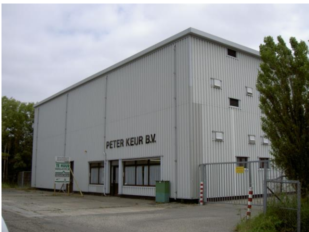
In de jaren '70 is de bollenshuur "ingepakt" in stalen damwandprofielen en is de achtergevel wit geschilderd. Deze wijzigingen zijn bij restauratie en herbesteding te herstellen.
