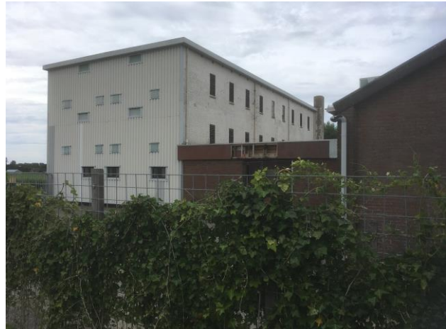
In de jaren '70 is de bollenshuur "ingepakt" in stalen damwandprofielen en is de achtergevel wit geschilderd. Deze wijzigingen zijn bij restauratie en herbesteding te herstellen.
