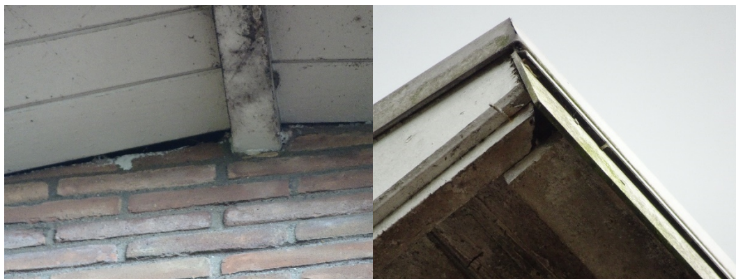
Figuur 3.3 Openingen onder en in dakoverstek Willem de Zwijgerlaan 31
