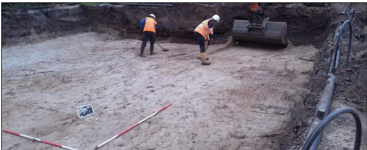
Figuur 2. De aanleg van het vlak in het westen van WP7.
