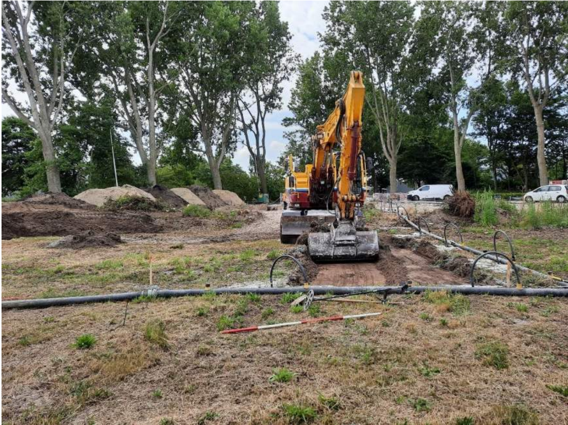
Figuur 2. Begin van de aanleg van het vlak. Zie ook de bronbemaling rondom de werkput.
