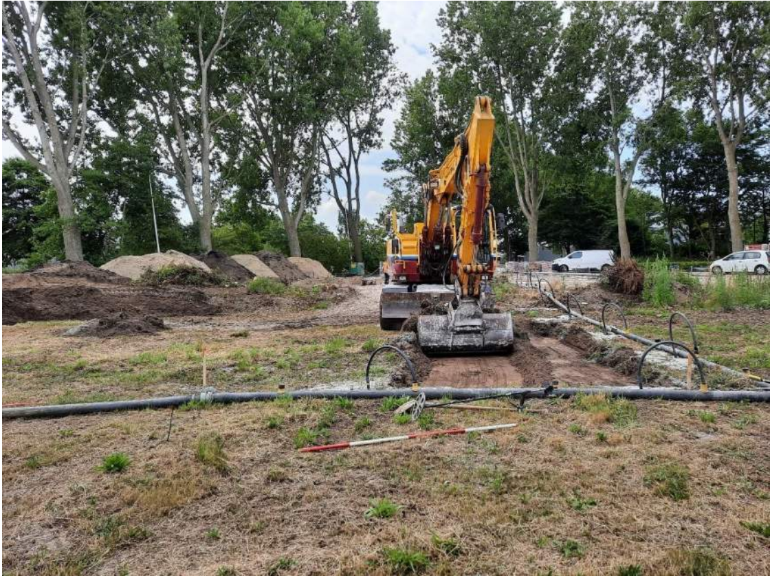
Figuur 2. Begin van de aanleg van het vlak. Zie ook de bronbemaling rondom de werkput.
