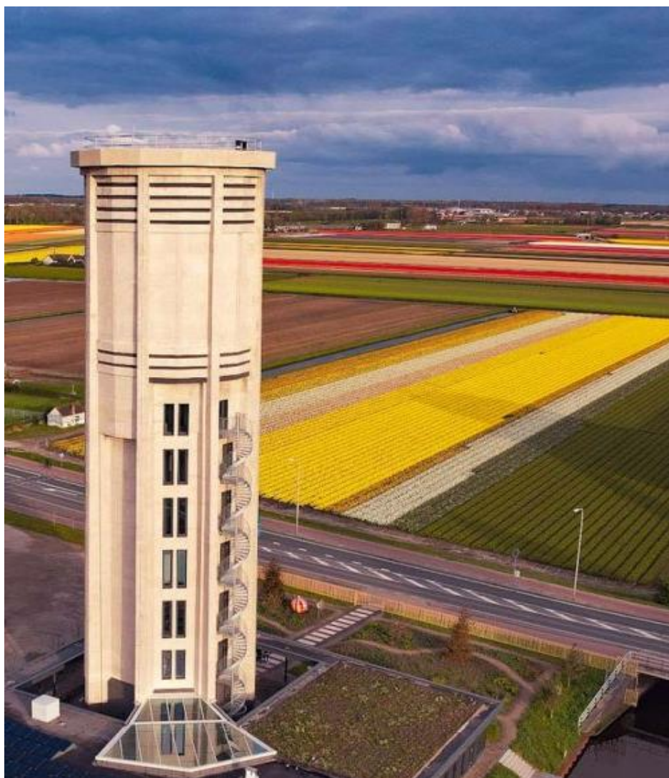
Watertoren Bollenstreek, Hillegom
