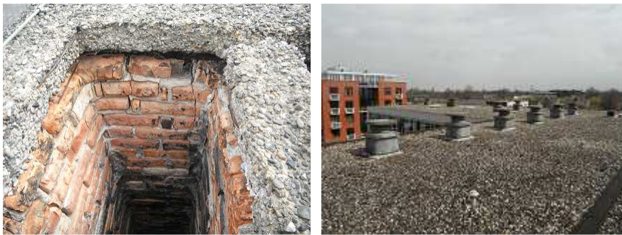
Figuur 4. Schacht van schoorsteen (links). Overzicht ventilatie-structuren Bloemswaard.
