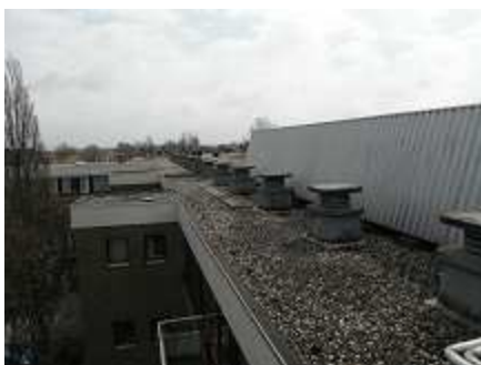
Dak Bloemswaard met aluminium opbouw.
