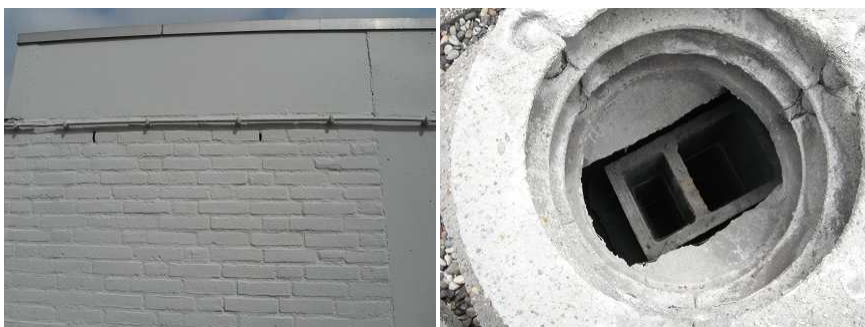
Liftopbouw boven op dak (links). Ingang ventilatieschacht zonder dekselplaat (rechts).
