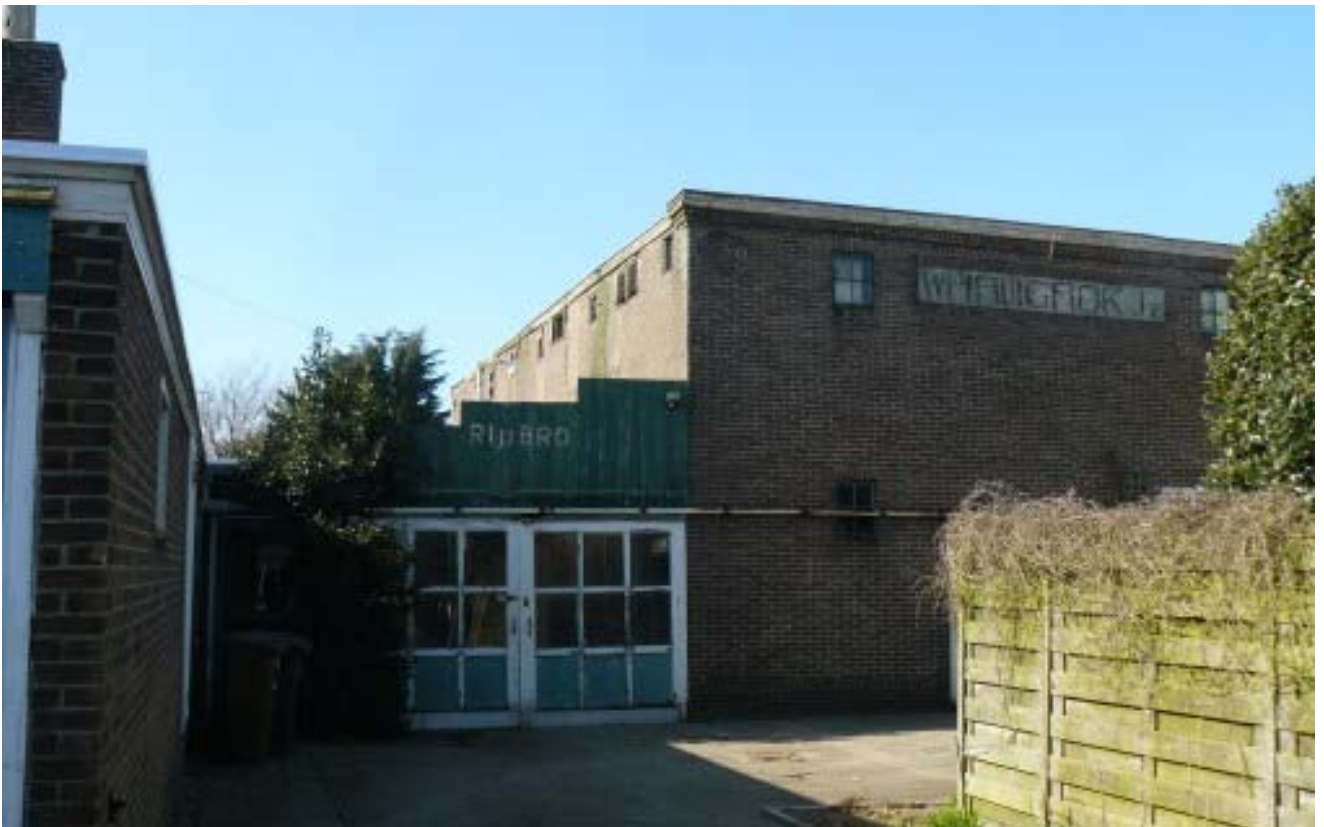
Sloop van de bollenschuur op 3A scheidt mogelijkheden voor ontsluiting van de bollenschuur op Zuider Leidsevaart 2A (Rijksmonument).
