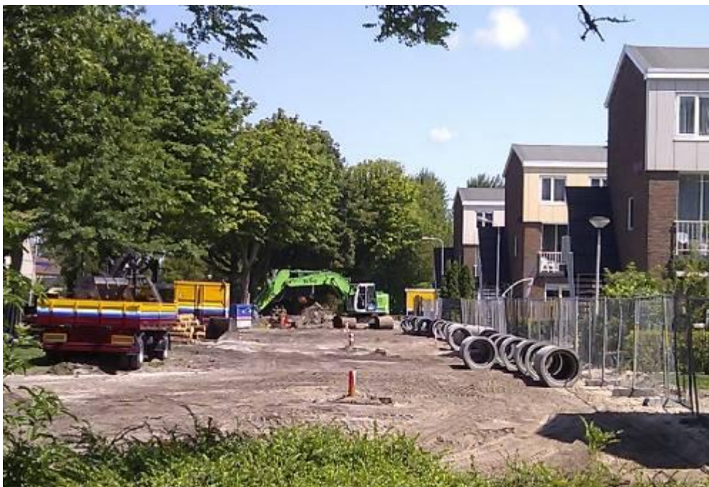
Figuur 3: aanleg regenwaterriool Prinsesmargrietplantsoen - Mauritslaan
