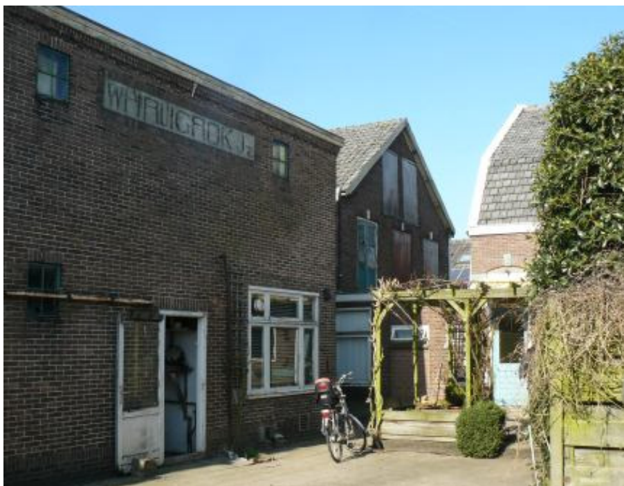
Links de te slopen lage bollenschuur met plat dak (1924), rechts daarnaast de te behouden bollenschuur met zadeldak, naast het Rijksmonument op 2A met mansardekap.
