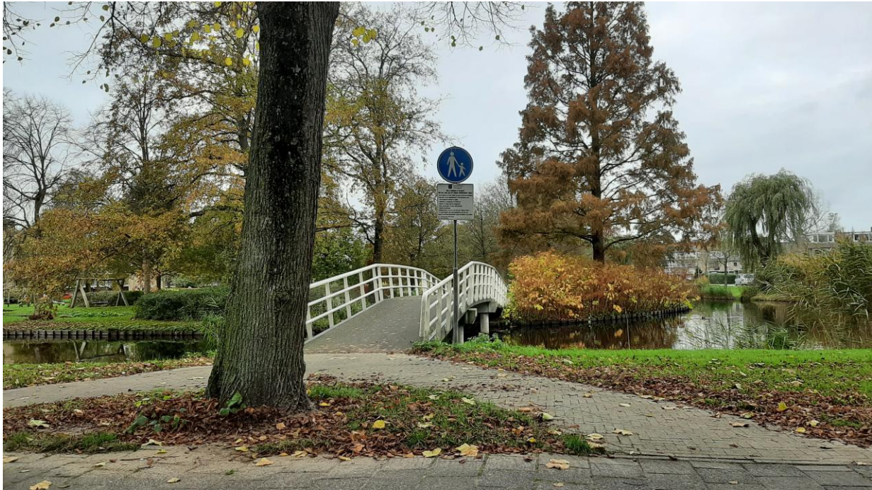
Figuur 18 Loopbrug die toegang geeft tot het park
